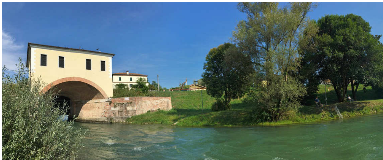
Fig. 9: Immagine dei Colmelloni lungo il Brentella Fonte: www.leqambientemediobrenta.it
