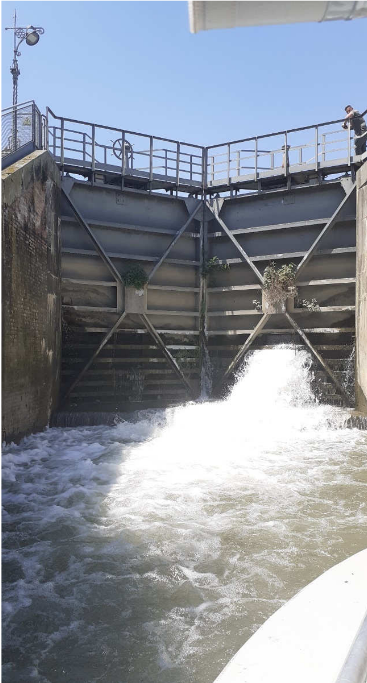
Fig. 8: Immagine effettuata a bordo dell'imbarcazione Sant'Agostino 1227, in attesa del riempimento della camera della conca di navigazione di Battaglia Terme. Fonte: foto dell'autrice.
