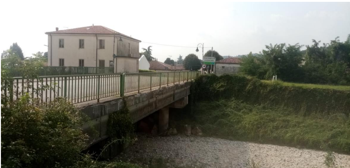
Immagine 3: il ponte sul fiume Chiampo, all'ingresso di Montebello Vicentino, presso cui Luigi Piccoli fu ferito mortalmente, durante uno scontro a fuoco con alcuni soldati tedeschi, la mattina del 10 settembre 1943 868 .
