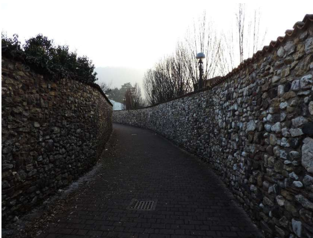
Fig. 3) L'aspetto attuale di via Busia, cinta per buona parte della sua lunghezza da muri, in parte conservati in parte ricostruiti
