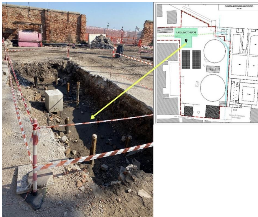
FIGURA 14: ZONA DI PRELIEVO DEL CAMPIONE DI TERRENO ALL'INTERNO DELL'AREA HOT-SPOT. È POSSIBILE NOTARE L'INIZIO DEI LAVORI DI SCAVO DI TALE ZONA.
