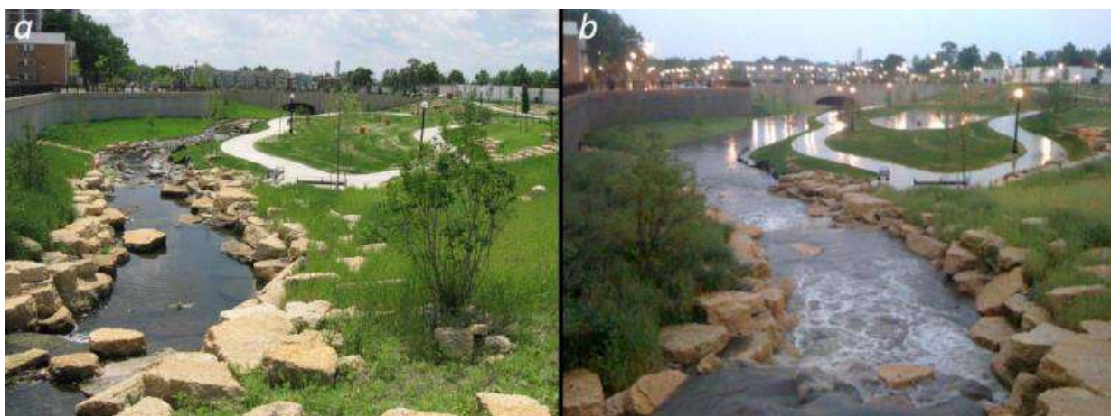
Figura 47: Esempio di vasca di contenimento con laghetto interno di bioritenzione da realizzare in Via Volti a Santorso, durante una giornata normale (a) e giornata di forti precipitazioni (b), Intervento 3
