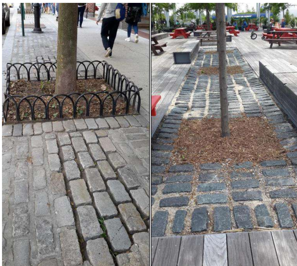
Figura 50: Esempi di fascia di pavimentazione porosa alberata da fare nell'intervento 6
