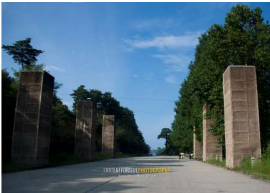
Figura 21 Lafforgue, North Korean anti tank invasion concrete blocks on the roadside on the Demilitarized Zone, Kangwon-do, Kumgang, North Korea / Blocchi di cemento anticarro nordcoreani su una strada nei pressi della zona demilitarizzata Courtesy: ericlafforgue.com
