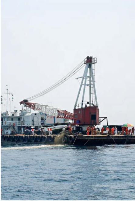
Figura 7. La nave Nantianzhu utilizzata per i lavori sul sito
