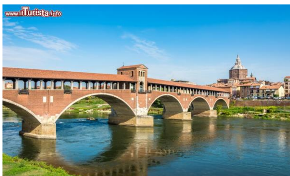
Figura 24: Ponte coperto a Pavia. 181
