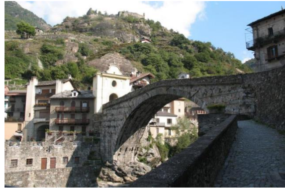
Figura 9: Il ponte romano di Pont-Saint-Martin 120
