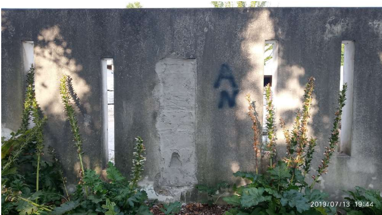
Figura 15. Il muro che originariamente divideva i due complessi scolastici era decorato con alcune fessure rettangolari. La più grande di essa era quella che anticamente permetteva l'ingresso all'altro gruppo di edifici: alla sua chiusura, attuata dai lavoratori del cantiere tramite una colata in cemento, i locali che inizialmente venivano chiamati escuela abandonada erano risultati inagibili, col risultato che le persone che usavano sostanze psicoattive illegali e vivevano in quegli edifici abbandonati si erano trasferiti nelle sale delle Figure precedentemente mostrate in questa tesi. Il riempimento era perfettamente visibile, accanto a due graffiti rappresentanti la lettera «A» e la lettera «N», circondato dagli immancabili arbusti. Fotografia scattata in compagnia di Santiago.
