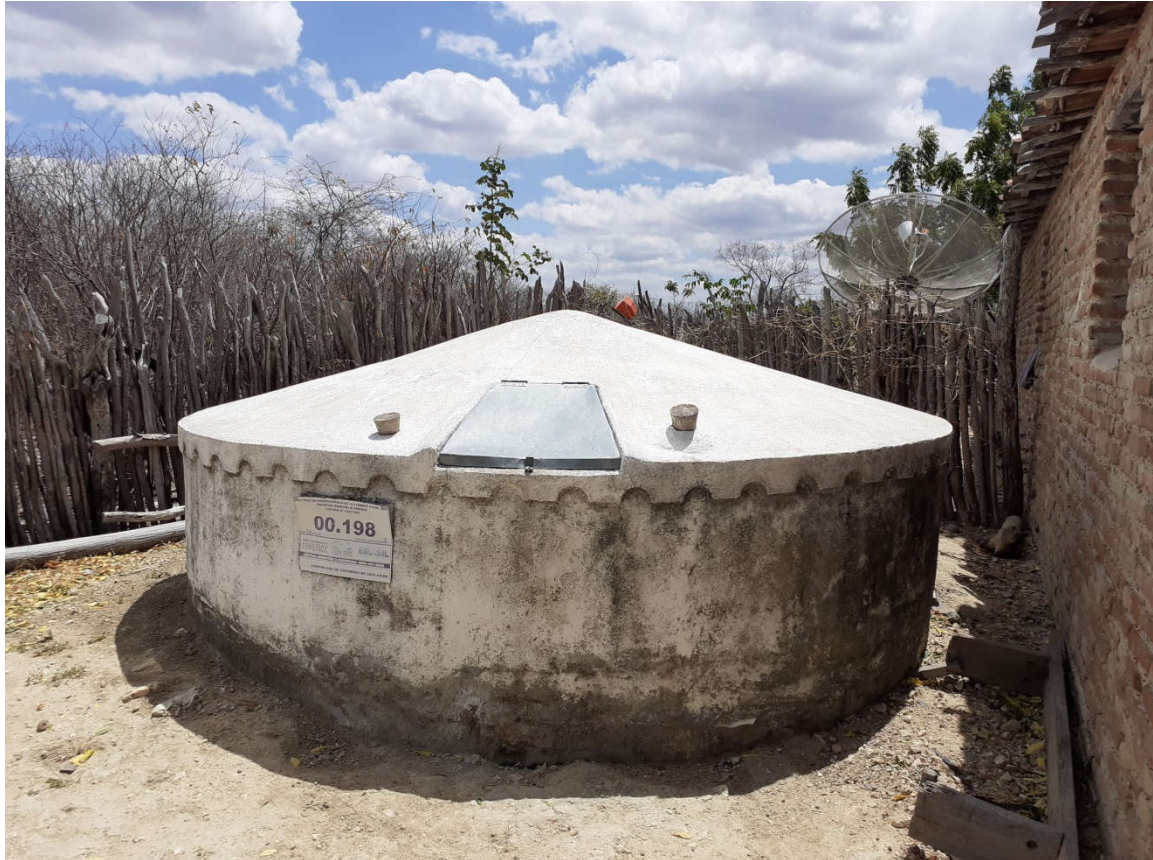
Figura 18: cisterna de bica nel cortile di casa del pescatore seu José, 08/06/2019, Novo Oriente. Le cisternas de bica sono annoverate tra le “tecniche di convivenza con il semiarido” e costituiscono le riserve d’acqua principali di cui si servono le famiglie situate in area rurale. Tali cisterne vengono costruite accanto alla casa poiché il luogo principale di captazione dell’acqua piovana sono le tegole del tetto; attraverso grondaie e semplici sistemi di tubature, l’acqua viene convogliata verso la cisterna che funge quindi da serbatoio chiuso ermeticamente per impedire l’ingresso di luce e la conseguente evaporazione dell’acqua. Due terzi della cisterna rimangono sotto terra, il che aiuta a compensare la pressione interna dell’acqua, dando stabilità alle pareti. (Fotografia di Berenice Rivolta)
