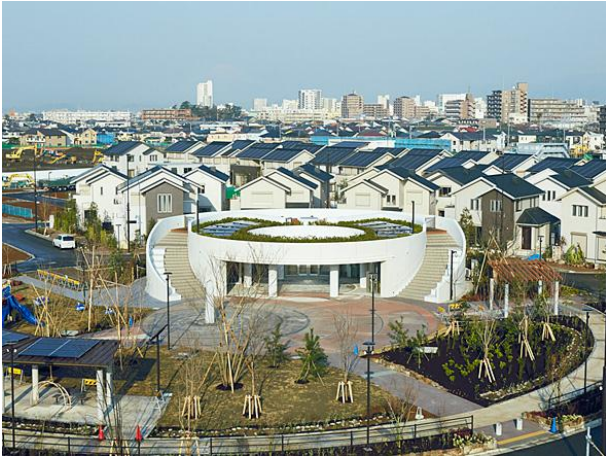
Figura 9: Centro Fujisawa SST. Fonte: https://fujisawasst.com/EN/photo/
