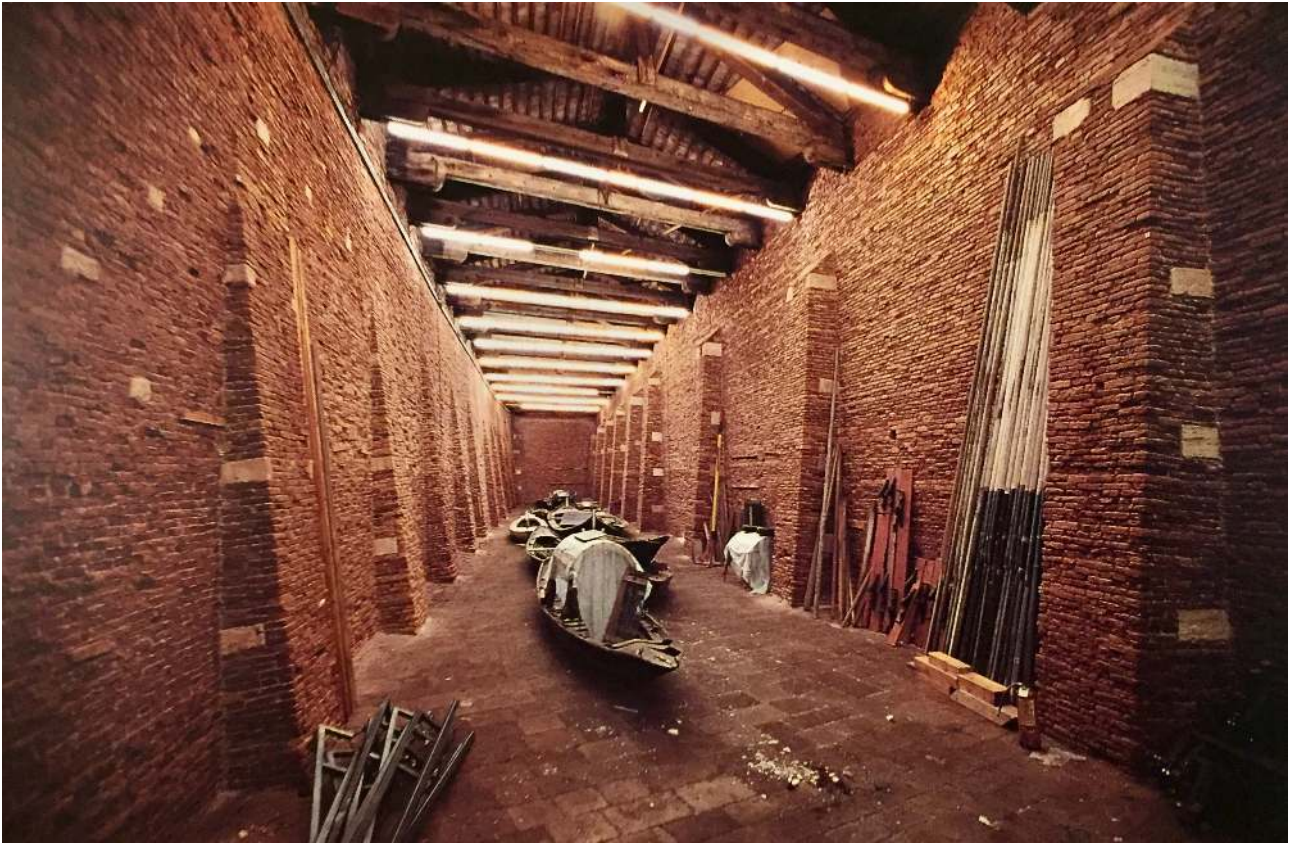
(fig. 27) Saleri a San Gregorio , interno; si nota molto bene la semplice struttura in laterizio con contrafforti di rinforzo la quale sarebbe in buona parte da assegnarsi alla fabbrica trecentesca.
