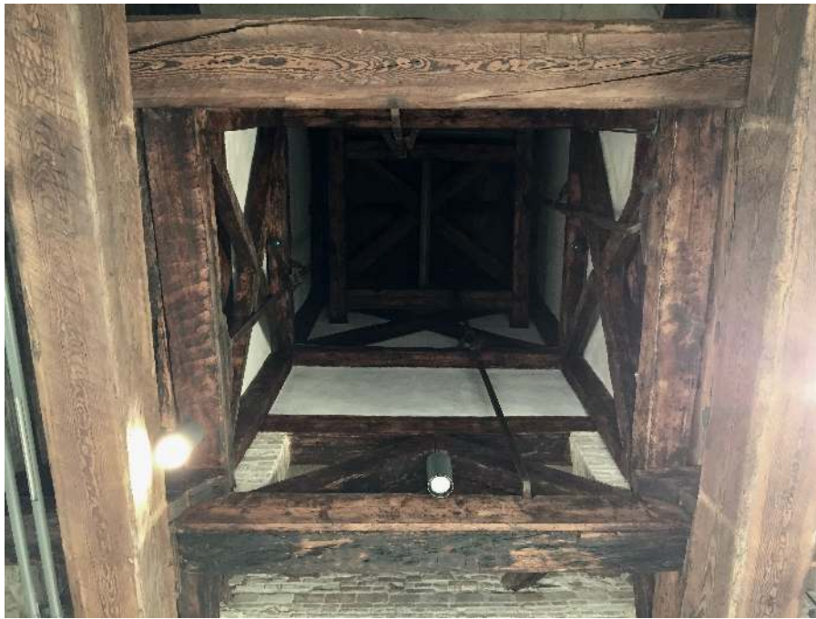
(fig. 23) Venezia, Punta della Dogana : particolare della torre dall'interno verso l'alto. Non è stato possibile risalire alla datazione della complessa struttura lignea ma si può ipotizzare che risalga ad un locale anteriore ai restauri del Benoni.
