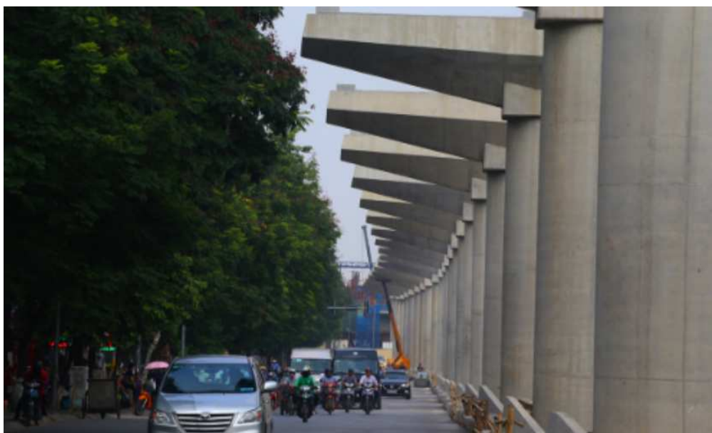
Piloni in costruzione della Metro Line 3 in Hanoi 169
