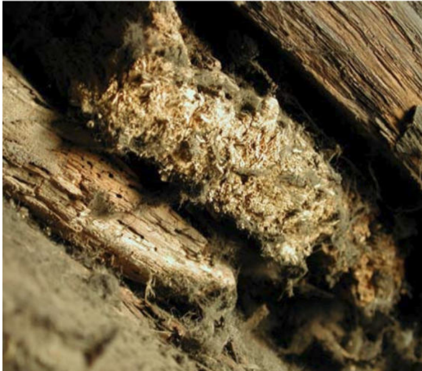
Fig. 28 Particolare di attacchi entomatici causati da coleotteri delle famiglie delle Anobiidae, Porta maggiore della basilica di Sant'Ambrogio, Milano.
