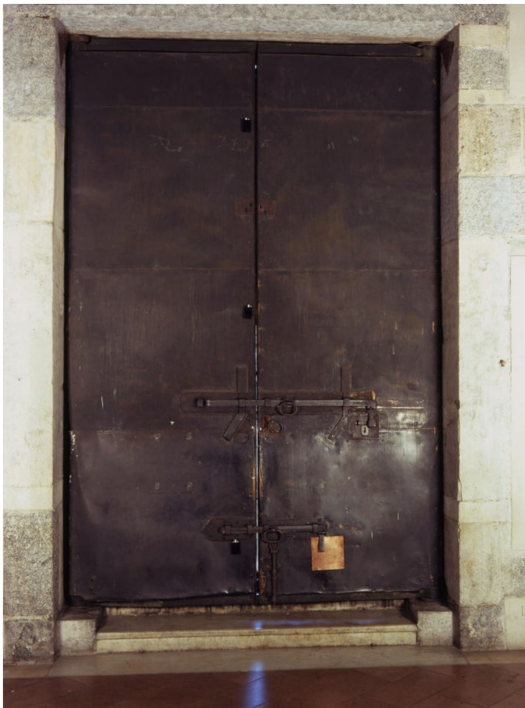
Fig. 30 Particolare delle placche in rame sul retro aggiunte durante il restauro del 1749-1751, Porta maggiore della basilica di Sant'Ambrogio, Milano.
