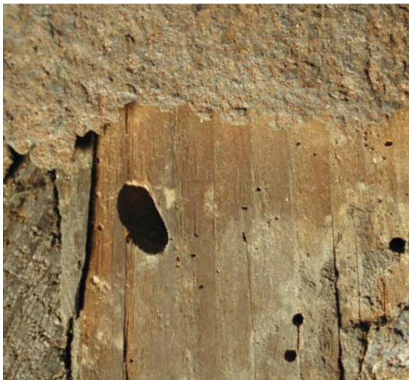
Fig. 29 Particolare di attacchi entomatici causati da coleotteri delle famiglie delle Cerambycidae, Porta maggiore della basilica di Sant'Ambrogio, Milano.
