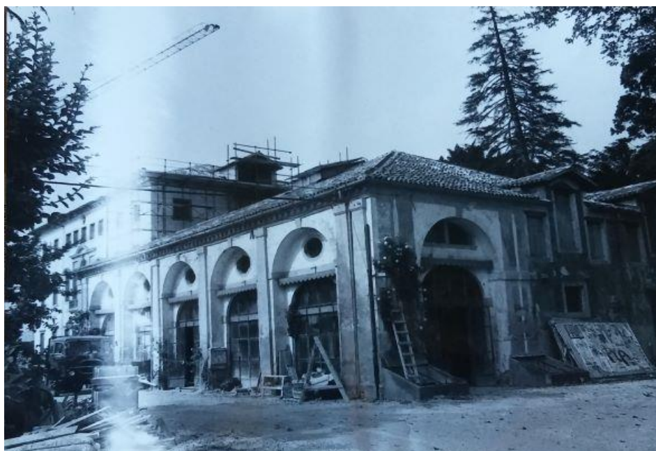
Figura 6. Lavori di ristrutturazione dell' orangerie (ca. 1948) Archivio di Palazzo Ximènes (Firenze)
