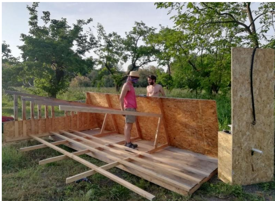
Figura 18: la costruzione delle docce solari alle Vignole. Fonte: Archivio Biennale Urbana.
