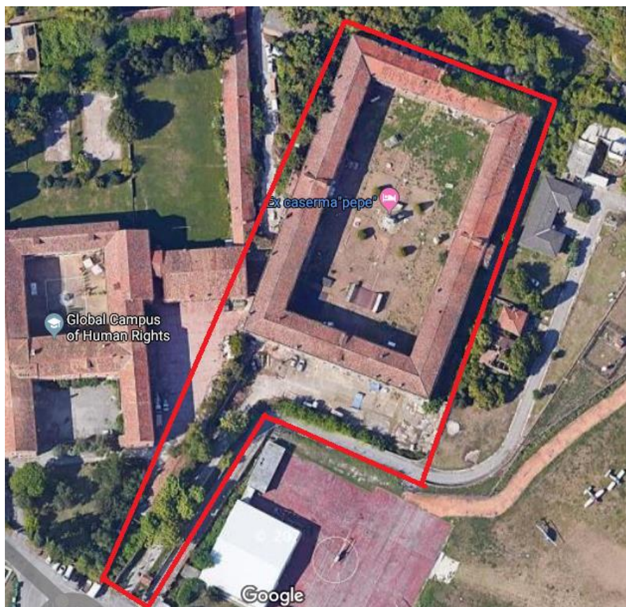
Figura 1: Vista aerea della ex Caserma Guglielmo Pepe ed edifici limitrofi. Fonte: Google Maps.
