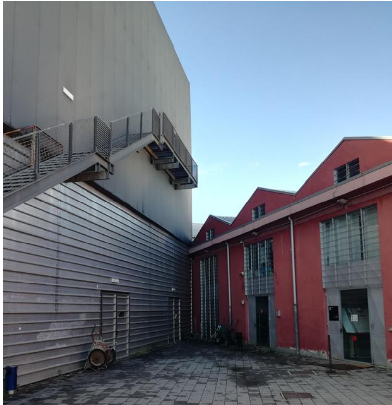
Figura 36: ingresso palco e laboratorio fonderie (sulla destra)
