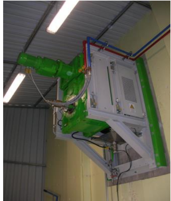
Figura 29 - Motoriduttore dell'agitatore ad aspo dell' EUCO
