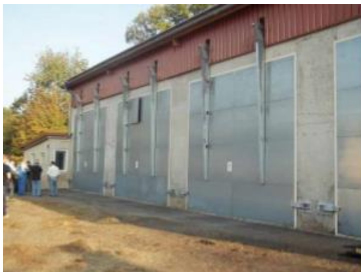
Figura 11 - Digestione BATCH in Germania
