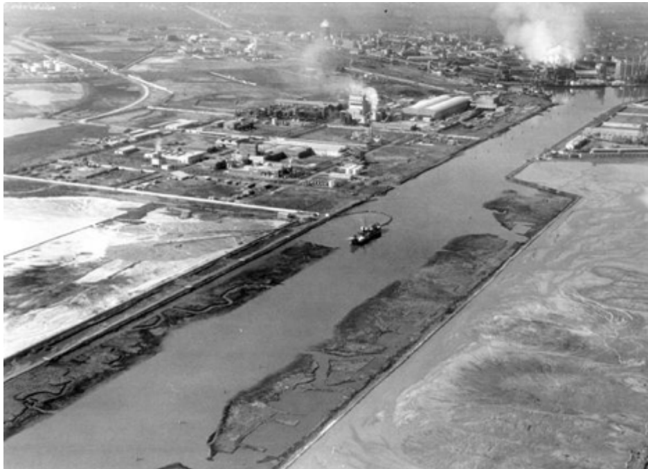
Imbonimento della macroisola nuovo petrolchimico – anni '50
