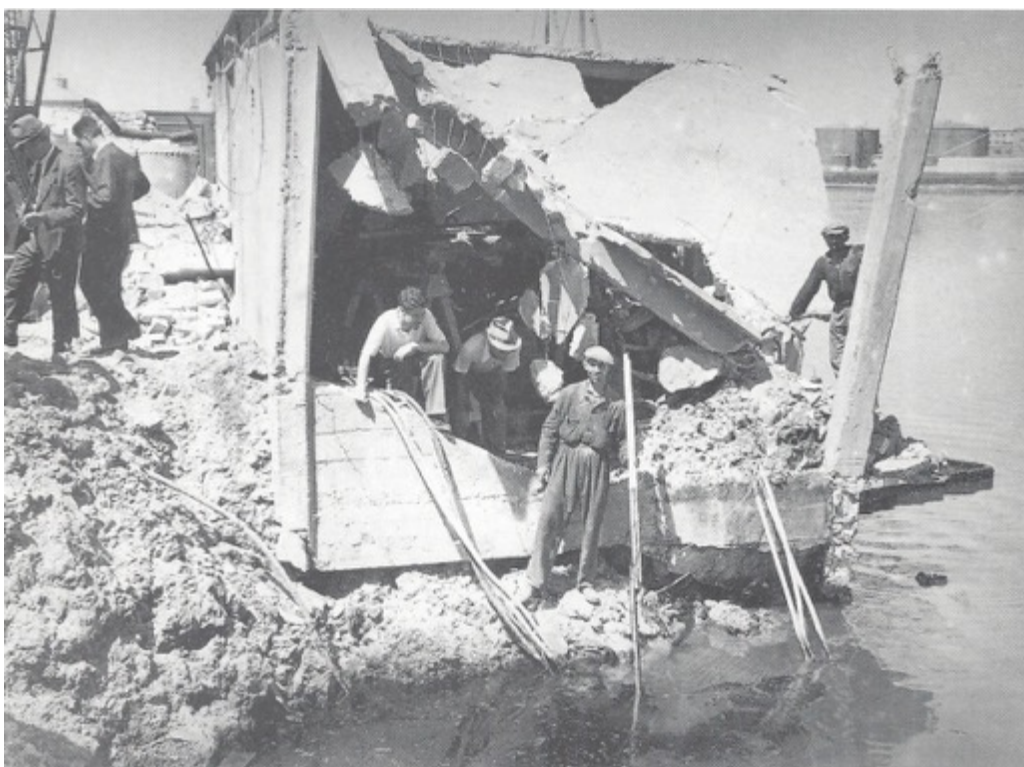
Lavoratori riparano i danni della zona industriale.
