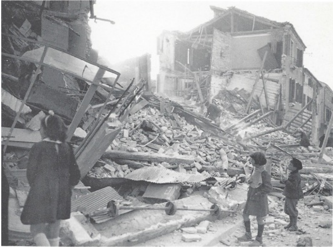
Macerie di case distrutte in Piazza Barche.
