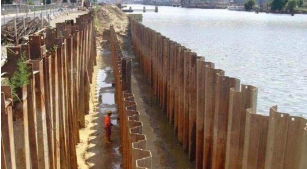
Esempio di opera di marginamento per contenere lo sversamento in laguna dovuto ad erosione delle sponde inquinate dei canali.
