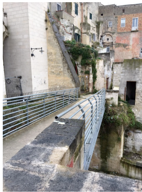
Immagine 5 – Stato attuale ponte in metallo (2019) 168
