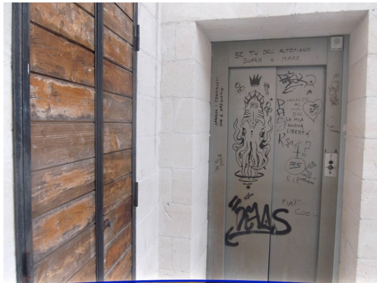
Immagine 2 – Porta dell’ascensore di via Commercio 165 (2018)
