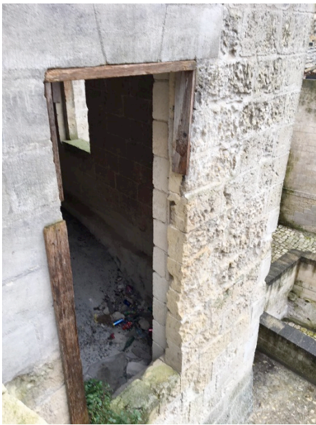
Immagine 4 – Stato attuale ascensore (2019) 167
