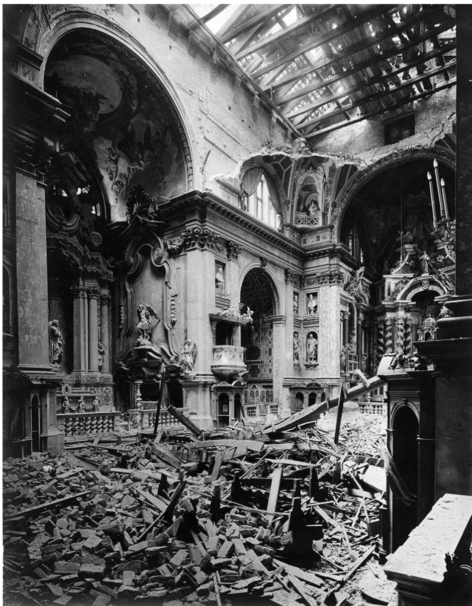
5. L'interno della Chiesa degli Scalzi dopo il bombardamento dell'ottobre del 1915.
