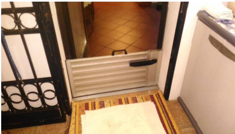
Figura 34. La paratia che viene montata in corrispondenza della porta d'ingresso al pianterreno della casa della famiglia Mercolino.
