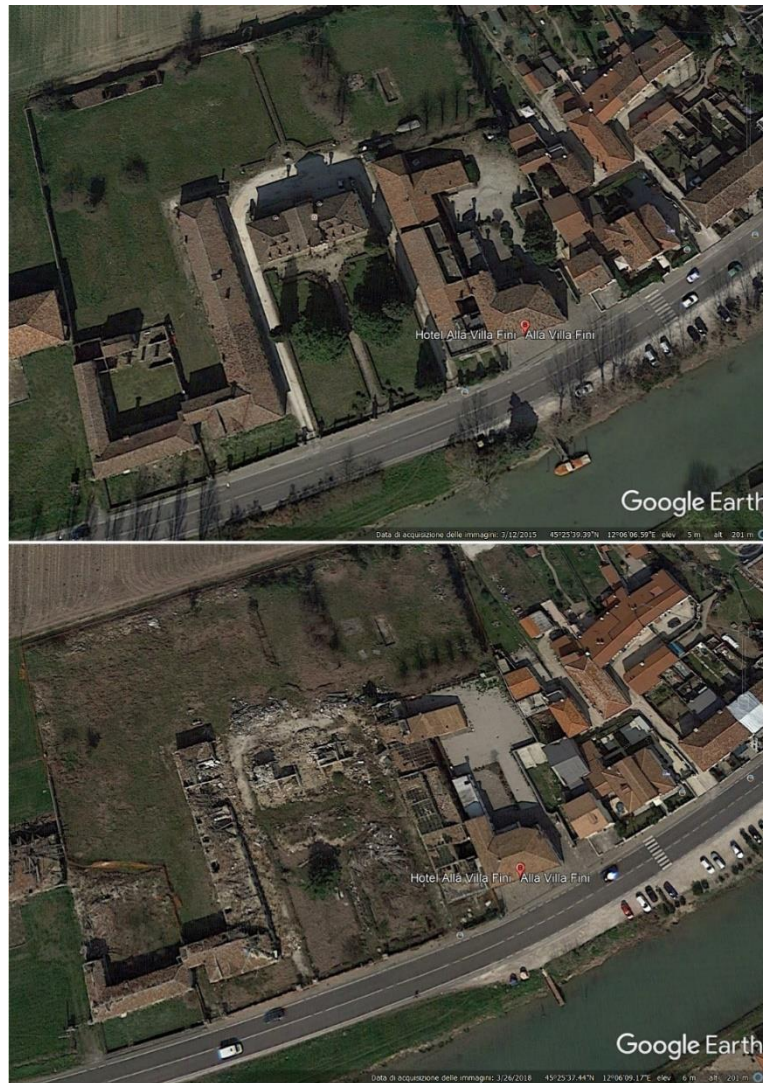
Figura 42. Vista dall'alto di Villa Fini prima e dopo il tornado del 2015. (Fonte Google Earth).
