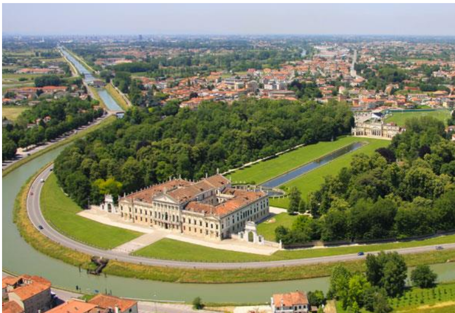
Figura 39. Veduta dall'alto di Villa Pisani, a Strà. (Sito dei Beni Culturali – Villa Pisani ( http://www.villapisani.beniculturali.it/galleria consultato il 24/08/2018).
