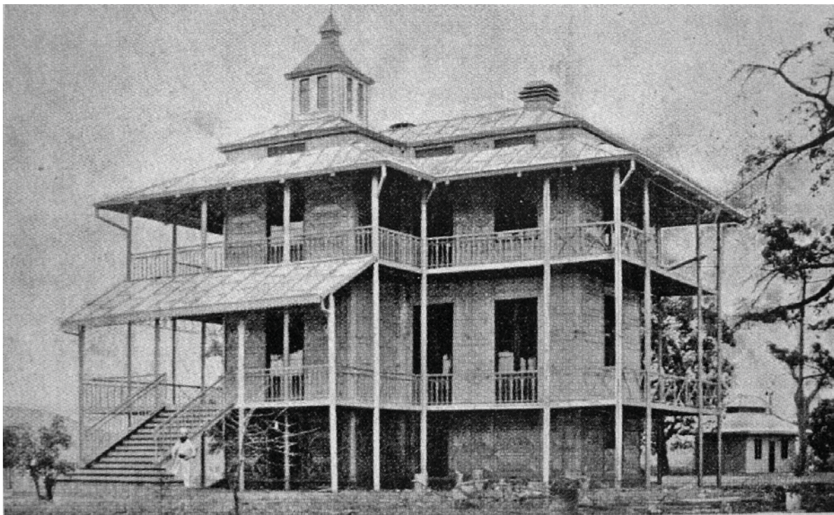
fig. 33 Residenza del governatore generale a Boma, Congo realizzazione 1888
