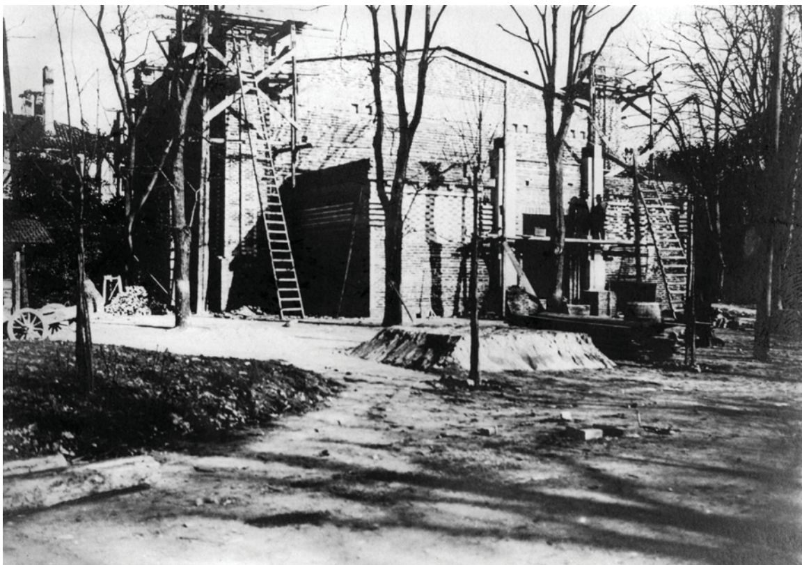
fig. 38 Il padiglione del Belgio in cantiere Venezia, 1907 (IRPA, Bruxelles, foto m284582)
