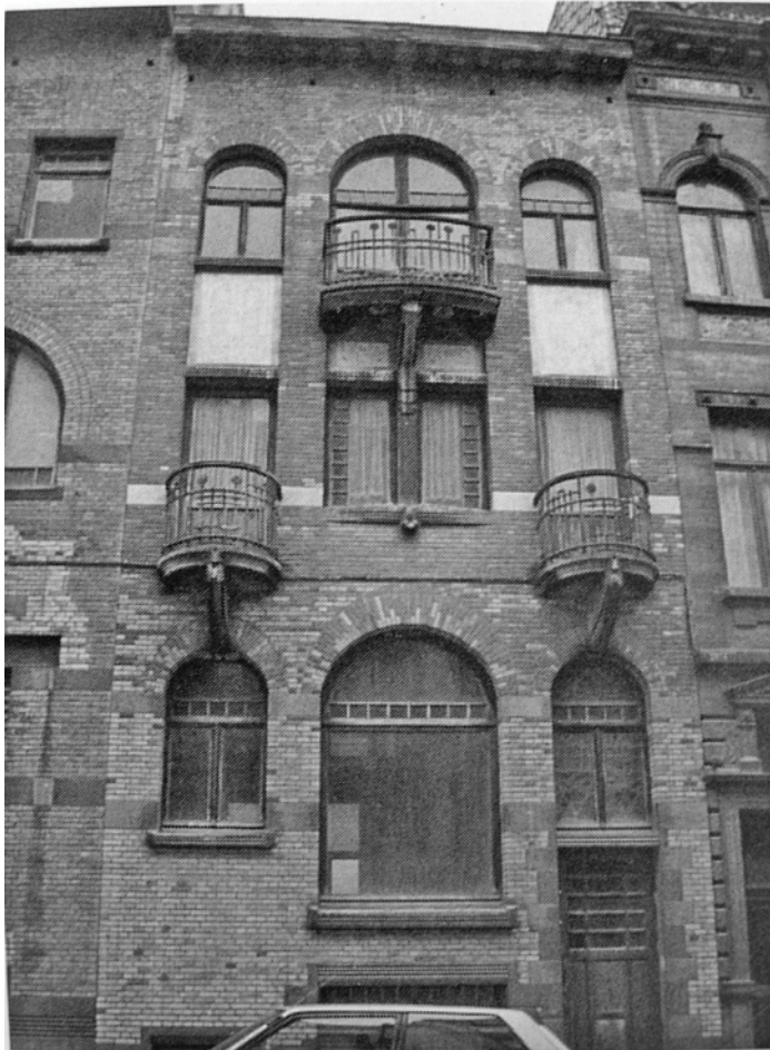
fig. 17 Léon Sneyers, Edificio residenziale, rue du Vallon, 28 Saint-Josse ten Noode, Bruxelles 1903
