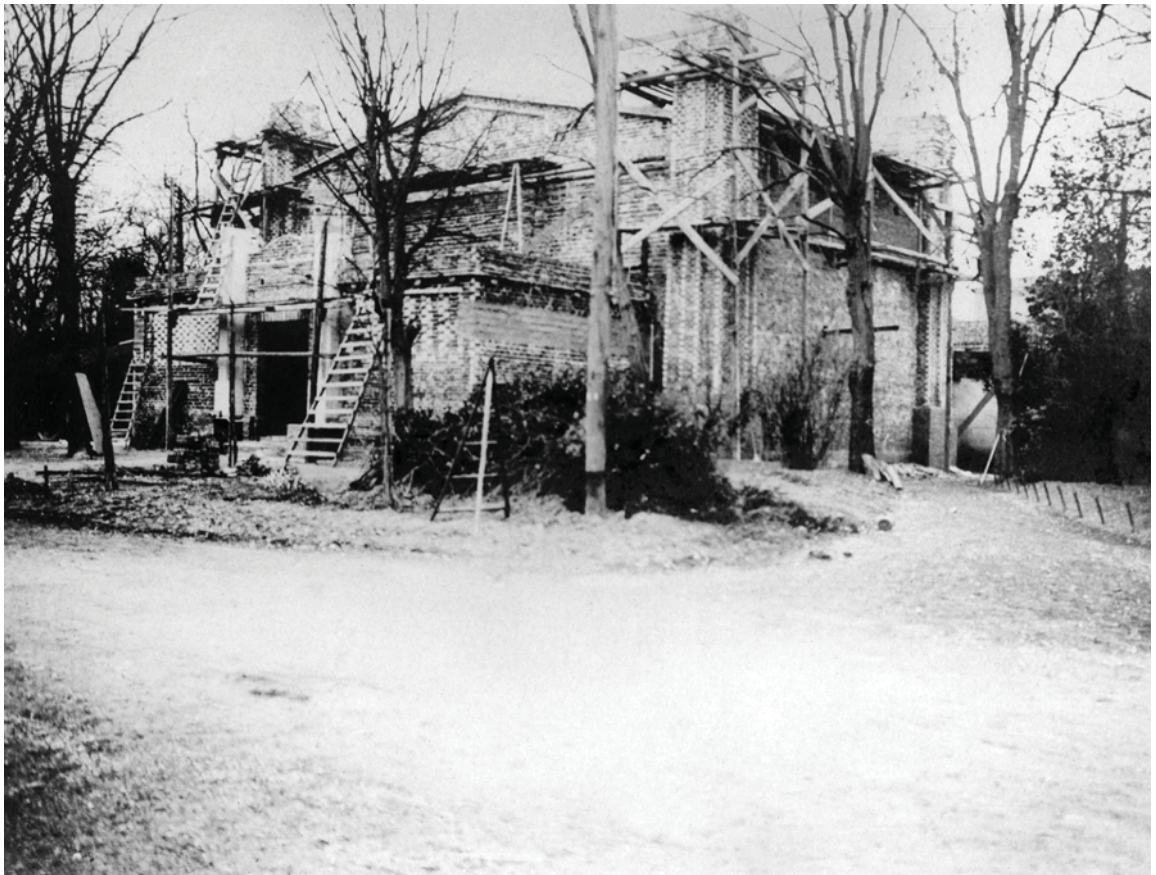
fig. 39 Il padiglione del Belgio in cantiere, Venezia 1907 (IRPA, Bruxelles, foto m284583)
