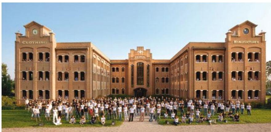
Figura 2.24: Sede di Replay di Asolo
