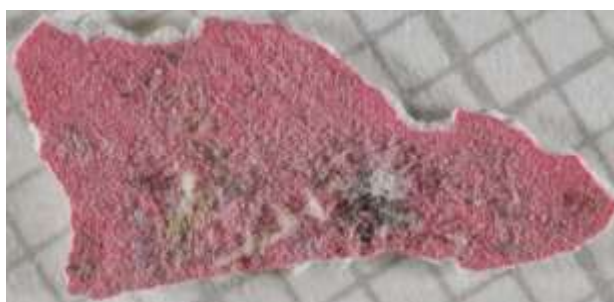
Foto 1. Campione di pittura rossa in cui è evidente l'estesa colonizzazione microbiologica.
